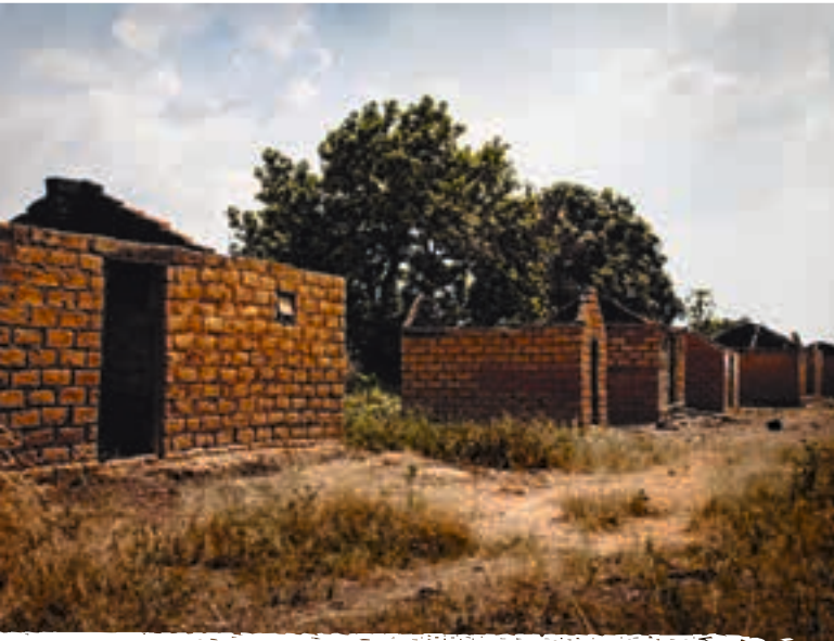
Beim Angriff auf das Dorf Vakap im Dezember 2013 wurden alle 130 Häuser zerstört, die Bewohner flohen. © Mark Kaye/Save the Children
